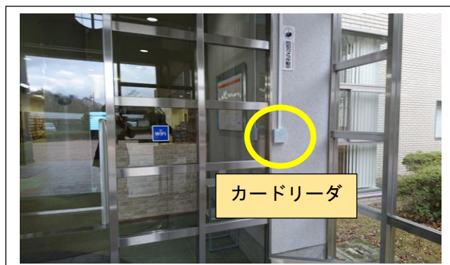
入退館口入館側
